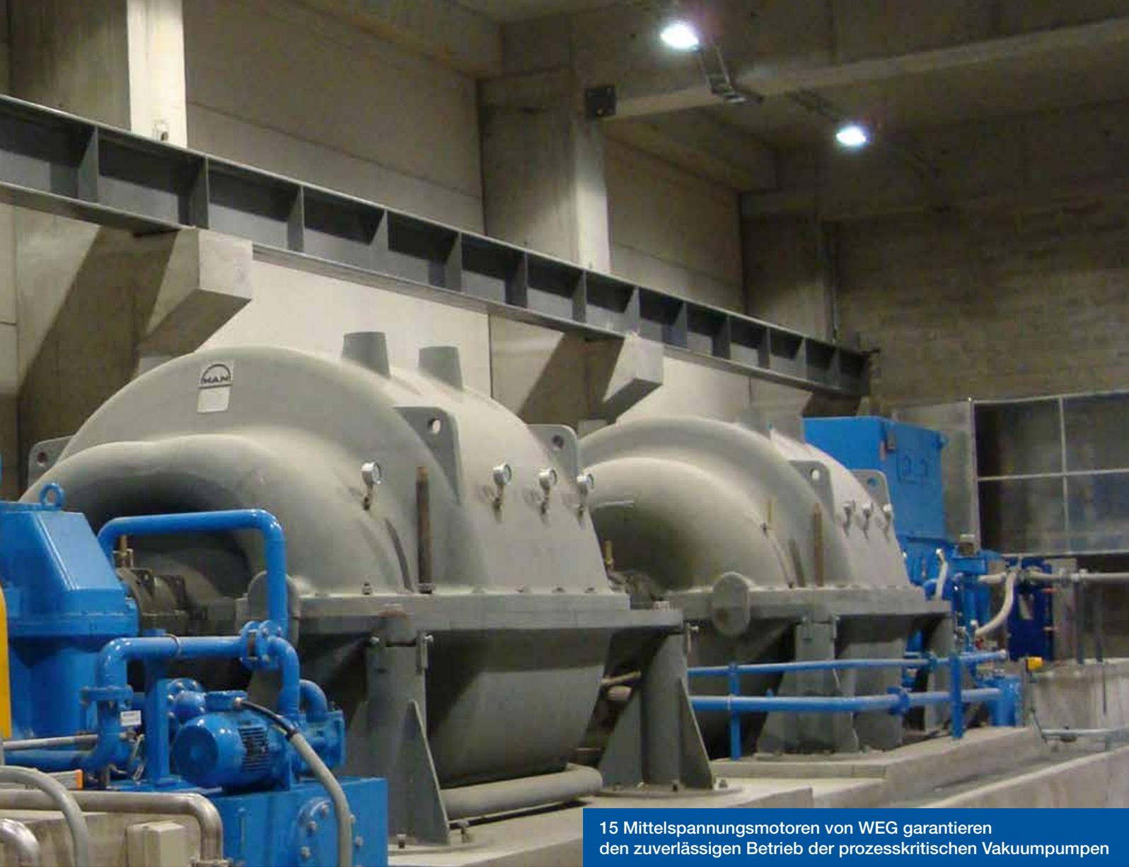
15 Mittelspannungsmotoren von WEG garantieren den zuverlässigen Betrieb der prozesskritischen Vakuumpumpen
